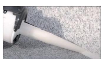
Tip: již při pokladce je možné tmelit spáry mezi jednotlivými schodovými prvky pomocí těsnících spárovacích tmelů, na bázi polyuretanu (např. Den Braven PU 50 FC).
