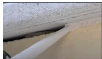
Spárovací tmel aplikujete k utěsnění mezer mezi lemem a podkladem.
